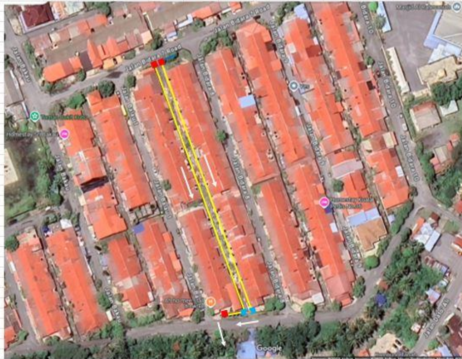
MENAIKTARAF LONGKANG DI TAMAN BUKIT KUBU FASA 1, MP KANGAR
