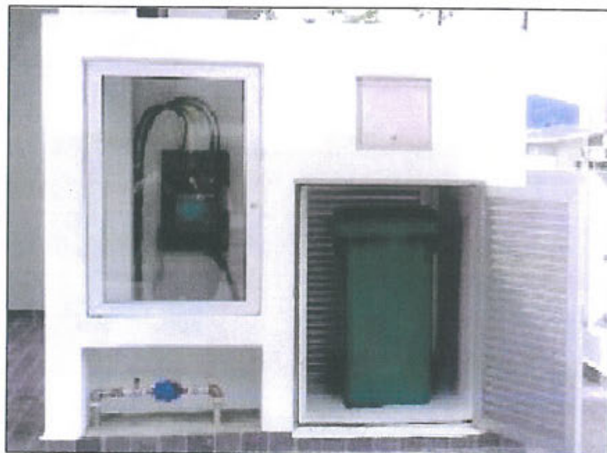
Gambar 6-5: Kebuk sampah yang boleh memuatkan satu (1) unit Tong MGB 120 liter
