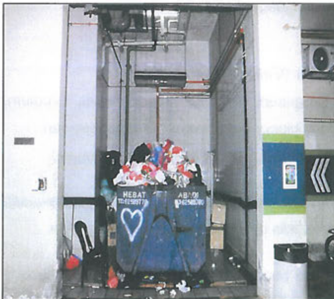
Gambar 6-3 : Pusat pemungutan sisa pepejal menggunakan tong RoRo
